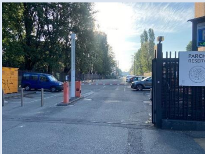
Via Ponzio 34 - Ingresso - con singola barriera e singola colonna
